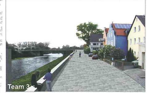
Team 3 Fotoanimation Untere Regenstraße: (22) Auf die brüstungshohen Schutzmauern werden mobile Elemente aufgesetzt.
