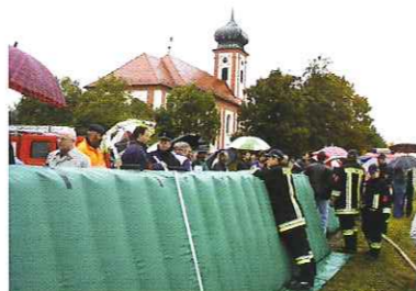
Mit Hochwasser gefüllte Kunststoffelemente
