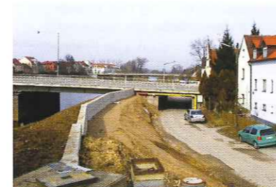
Lückenschließung Reinhausener Damm
