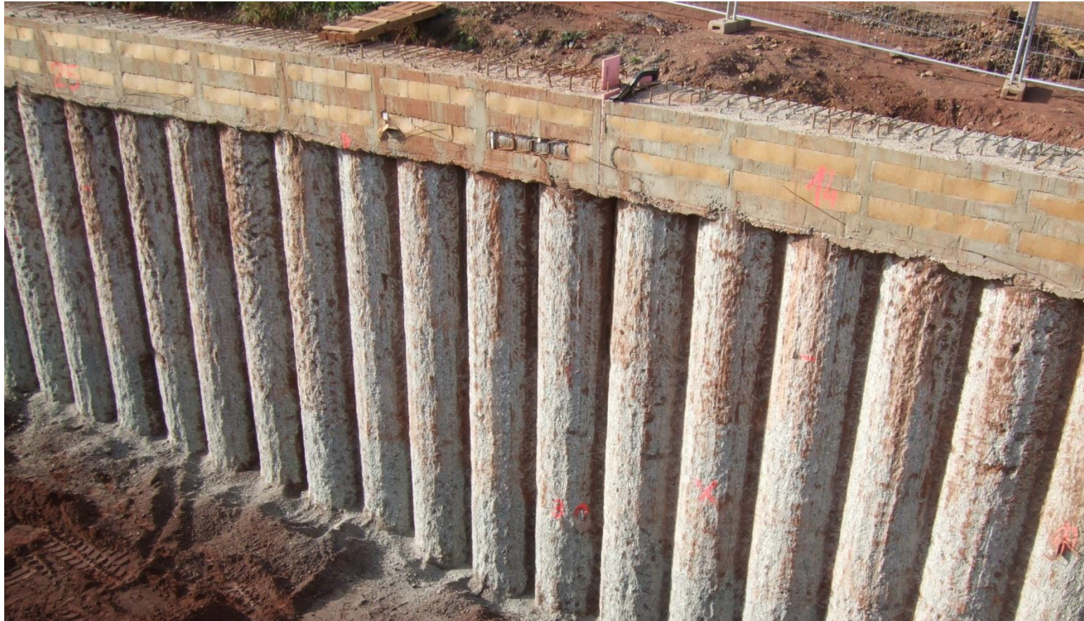
Bohrpfähle mit Kopfbalken
