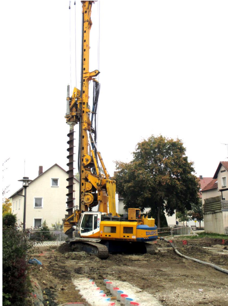
3.: Bohren und Betonieren der Pfähle
