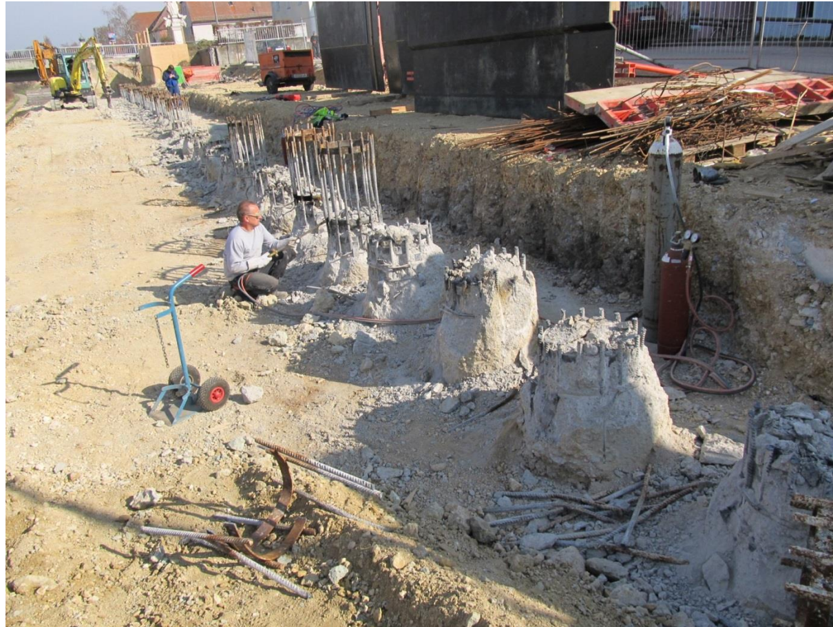
6.: Abstemmen der obersten Schicht der Pfähle
