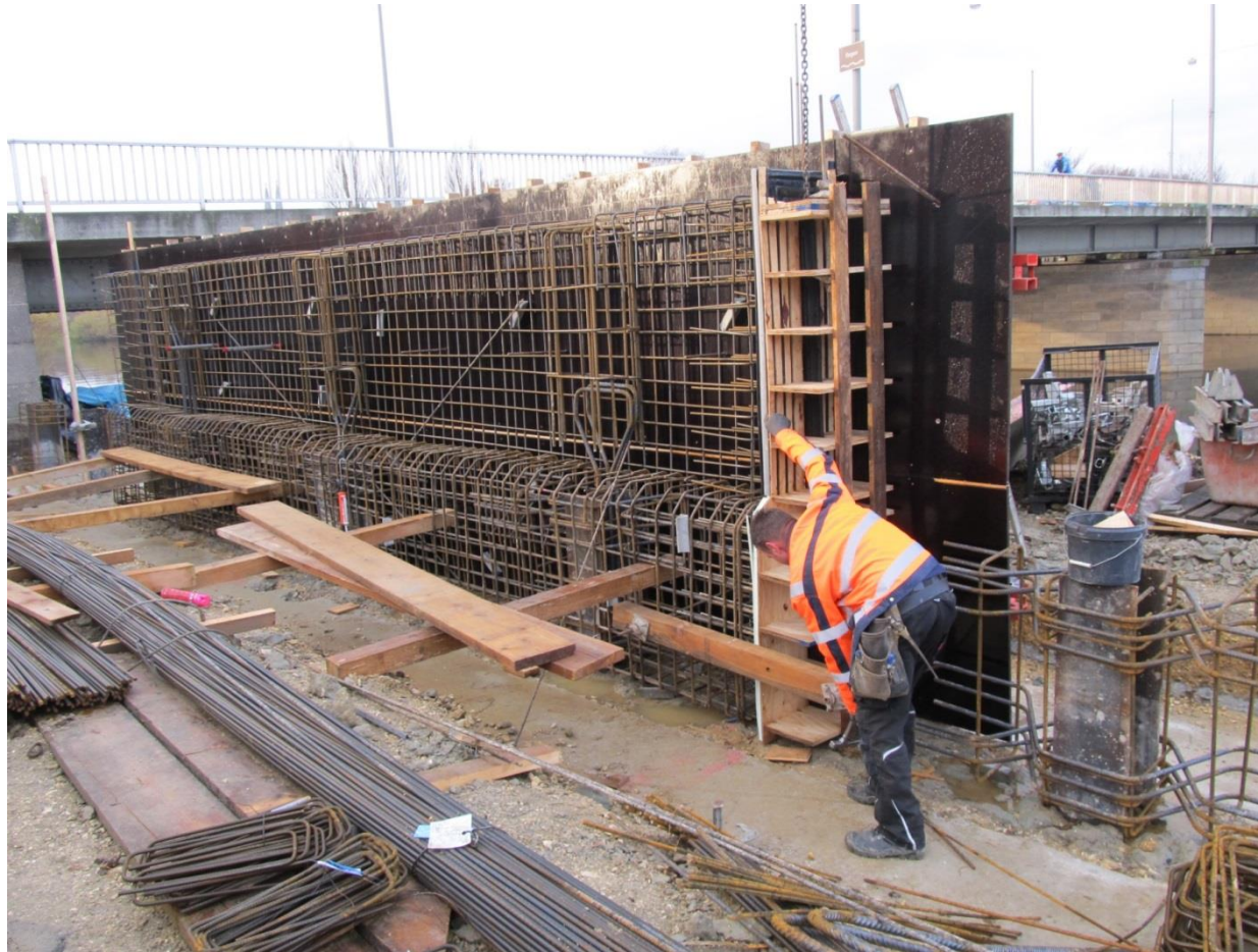
7.: Flechten der Bewehrung und Anbringen der Schalung
