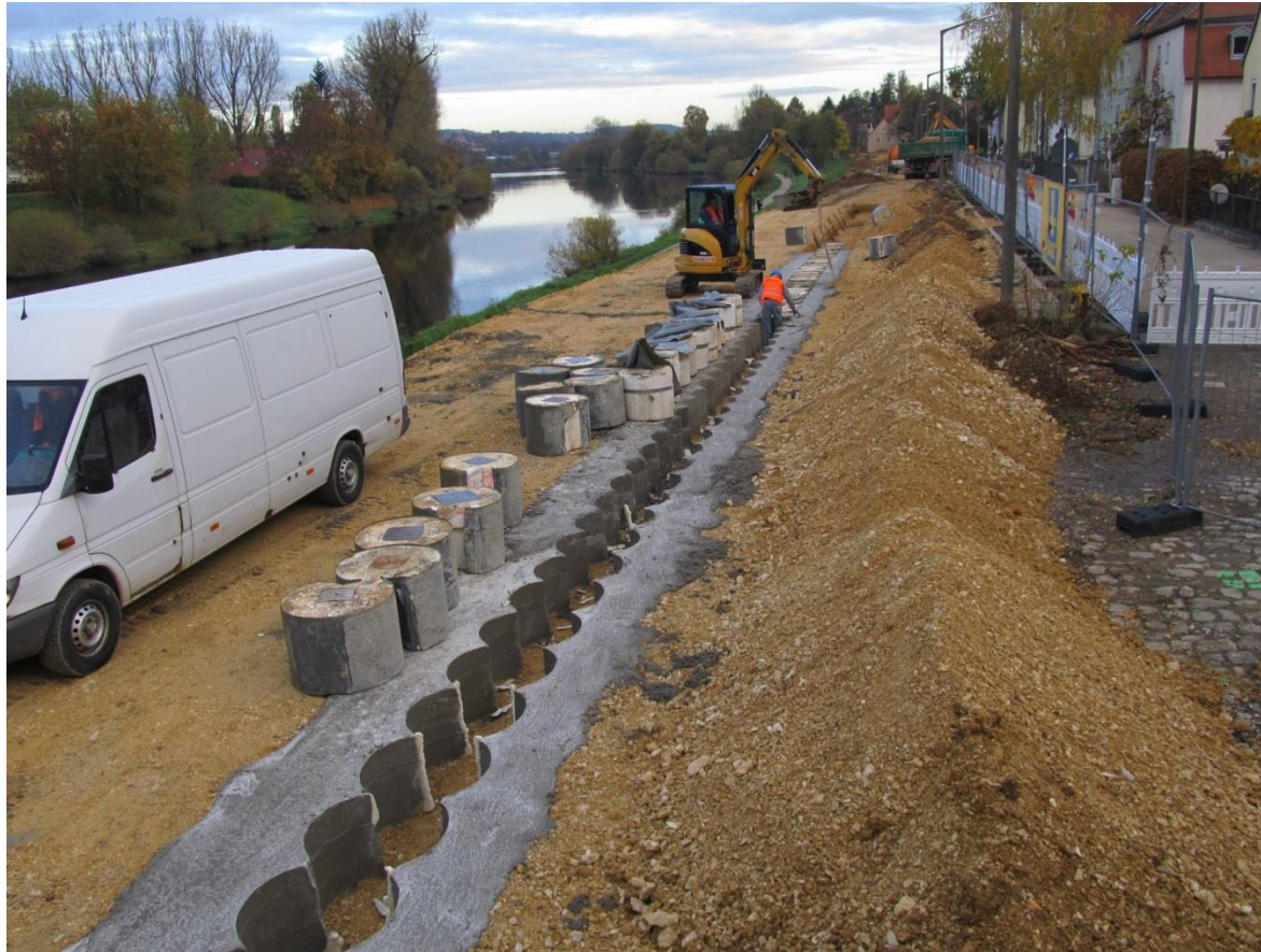
2.: Bohrschablonen aus Beton
