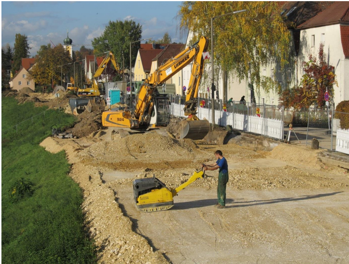
1.: Einrichten einer Baustraße
