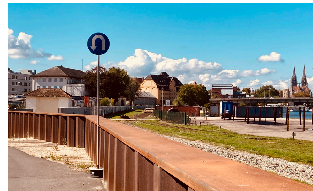
Ausführung des Hochwasserschutzes als sichtbare Spundwand im Hafenbereich
