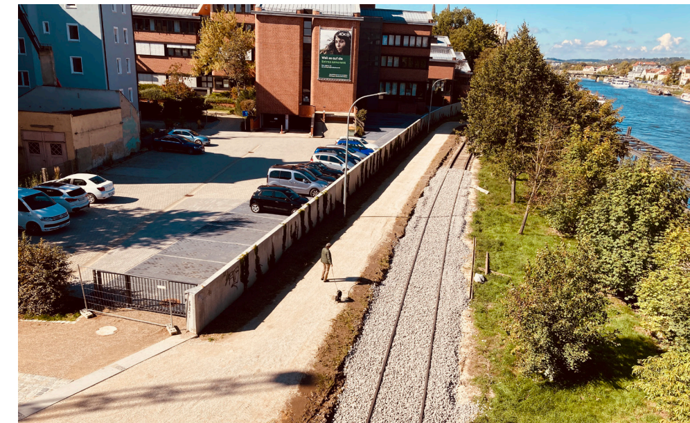
Blick auf die neue Hochwasserschutzmauer beim AOK-Gelände
