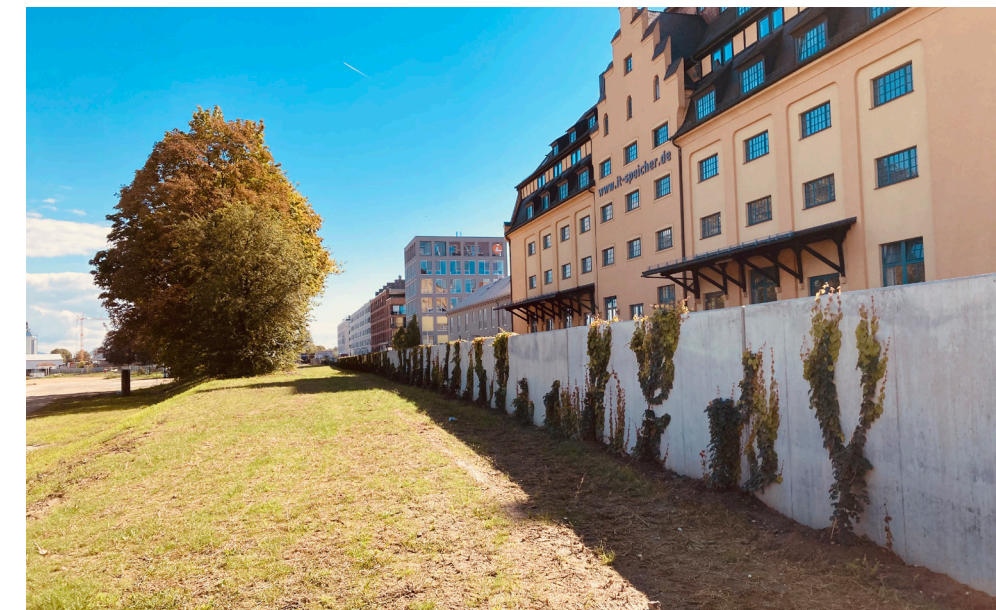
Begrünung der Hochwasserschutzmauer
