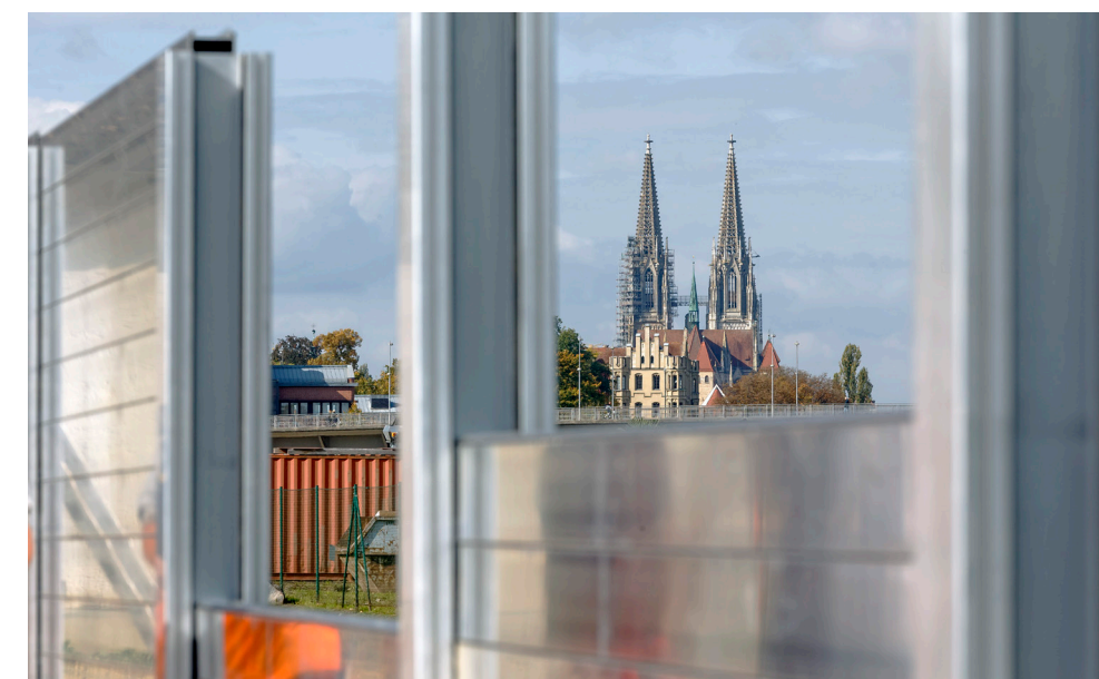
Blick durch die mobilen Elemente, die eine Öffnung in der Hochwasserschutzmauer verschließen
