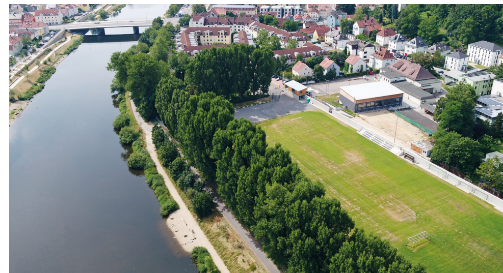
Hochwasserschutzmauer entlang des Fußballfeldes, darin integriert: Tribüne und Multifunktionsgebäude
