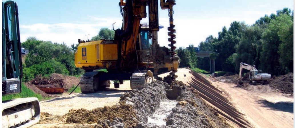
Bohren der Erdbetonwand
